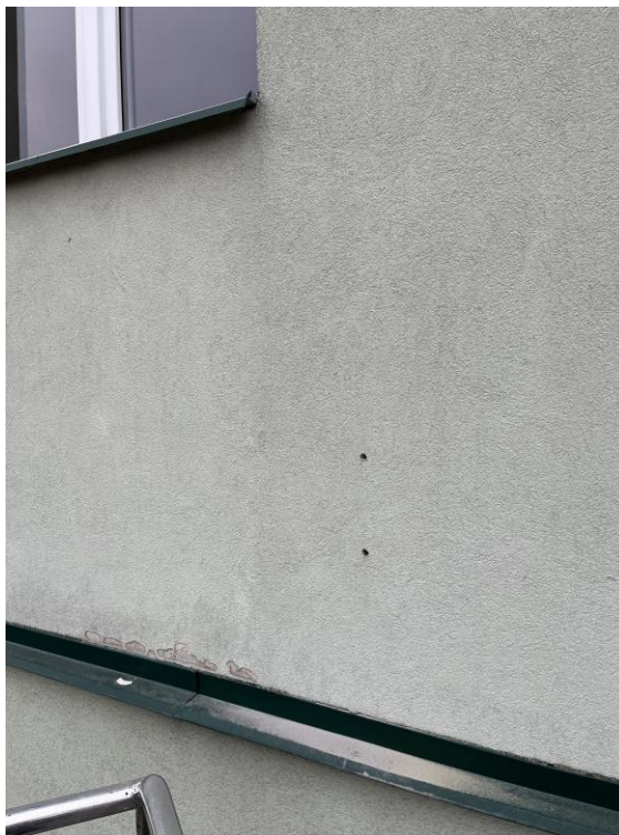
Obrázek 2: Vrtané otvory pro ověření výšky věnců
