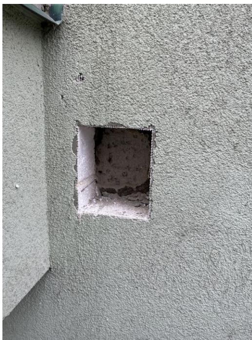
Obrázek 1: Místo provedení zkoušky tvrdosti betonu
